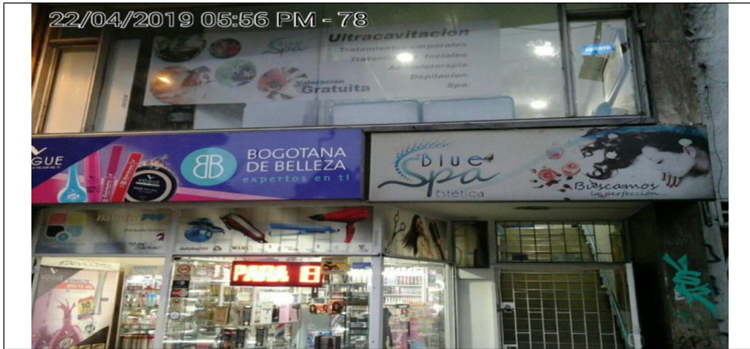
Fotografía No. 1. Elemento de publicidad exterior visual tipo AVISO EN FACHADA sin registro y elementos no permitidos incorporados en ventanas.
